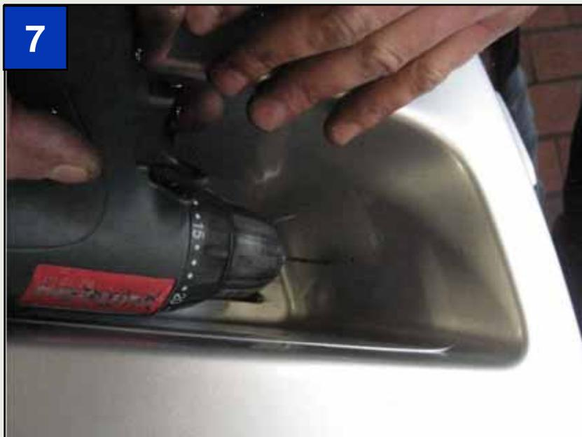
Anschließend werden die Löcher gebohrt und die Blenden fest verschraubt.
